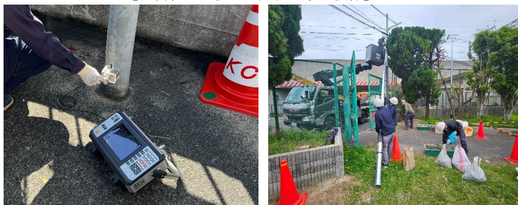
【自営柱の点検及び建替工事の様相】
