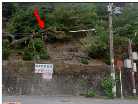
【生コン車電柱追突によるケーブル切断事故の模様】
