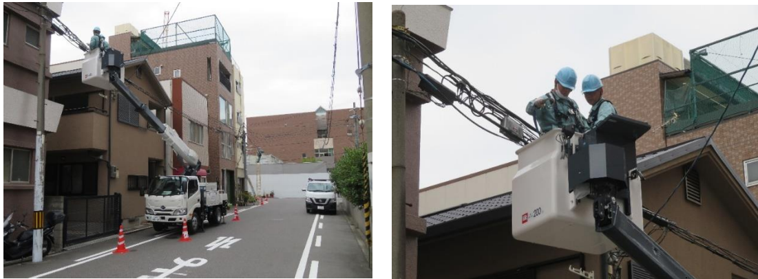
増幅器の交換作業(大阪市西区北堀江)
